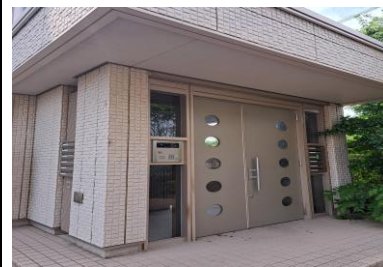
エントランスオートロック
