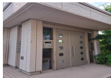
エントランスオートロック
