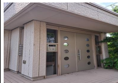
エントランスオートロック
