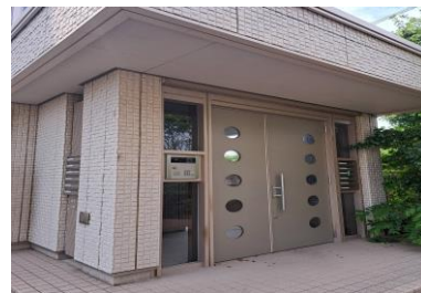
エントランスオートロック
